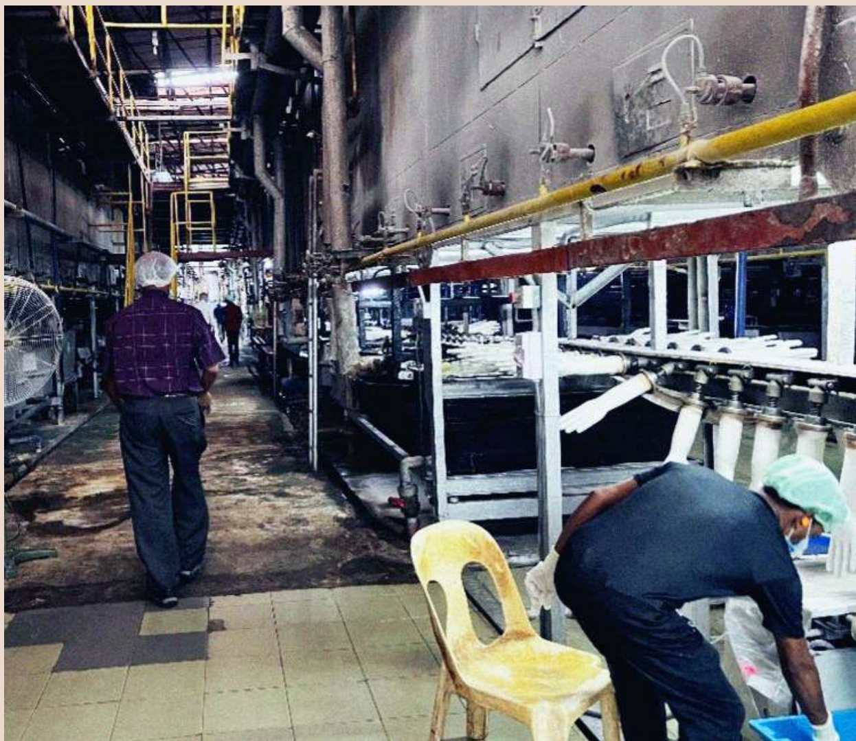
Produksjonslokaler på en hanskefabrikk i Malaysia.
